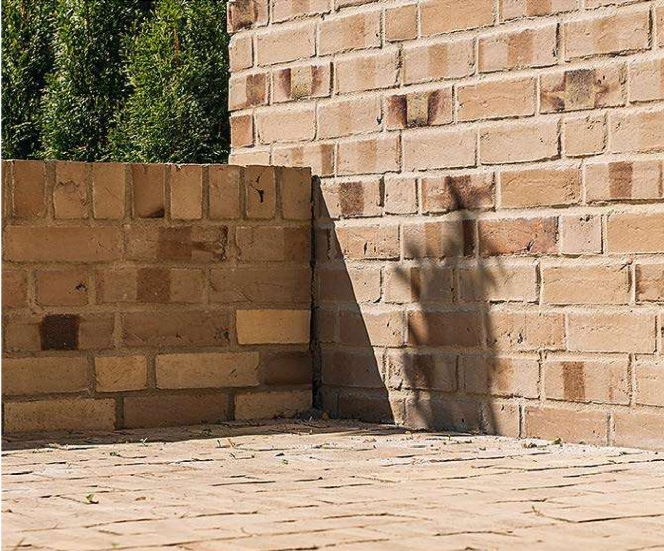
Уникальные характеристики клинкера позволяют использовать его одновременно, как для вертикальных, так и для горизонтальных поверхностей, причем для этого может использоваться один и тот же клинкерный кирпич или брусчатка. Возможности компании Muhr позволяют также произвести оба типа изделий, как стеновой клинкер, так и брусчатку одновременно, и соответственно одного и того же цвета.
