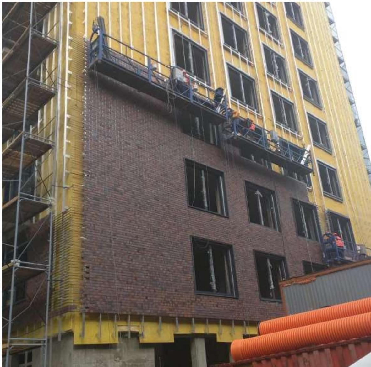
Только использование клинкерной плитки произведенной и обработанной по оригинальной технологии полностью соответствует внешнему виду клинкерного кирпича. Использование клинкерной плитки позволяет снизить стоимость м2 фасада по отношению к применению полноформатного клинкерного кирпича, при этом полностью передав его внешний вид.
